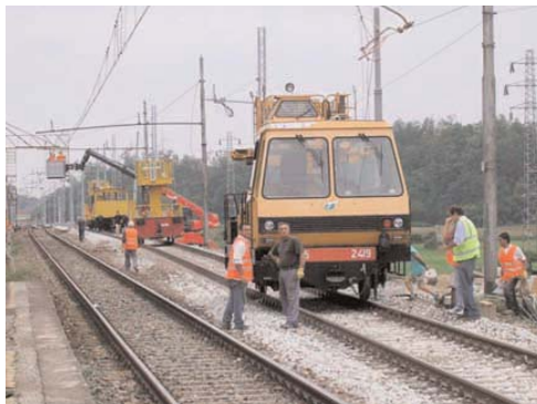
Cantiere di manutenzione ferroviaria.
