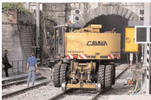
Cantiere di manutenzione ferroviaria.
